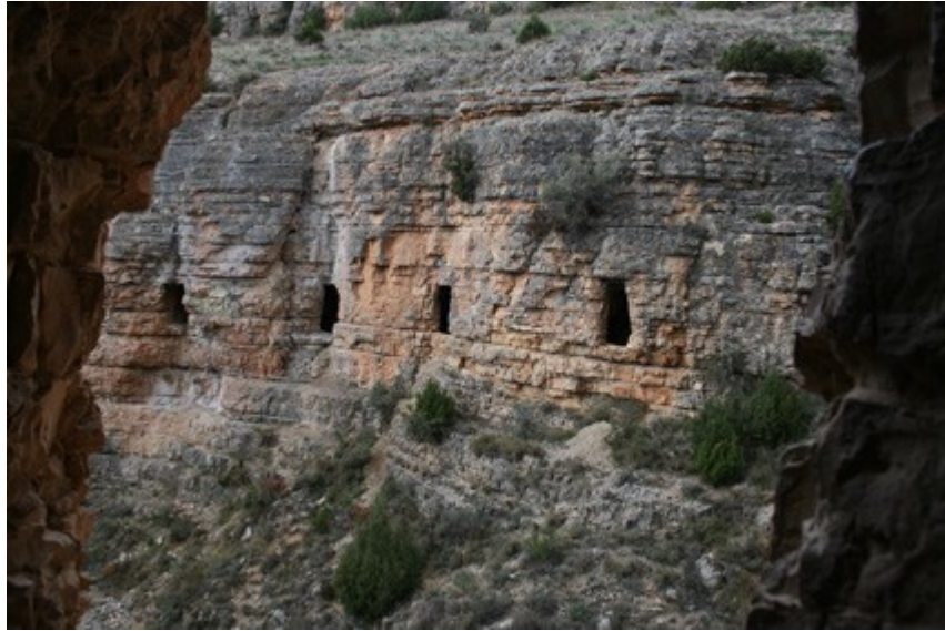
Loculi o lumina del acueducto en el Barranco de los Burros. (Foto: Roberto Lérica Lafarga 23/04/2008)
