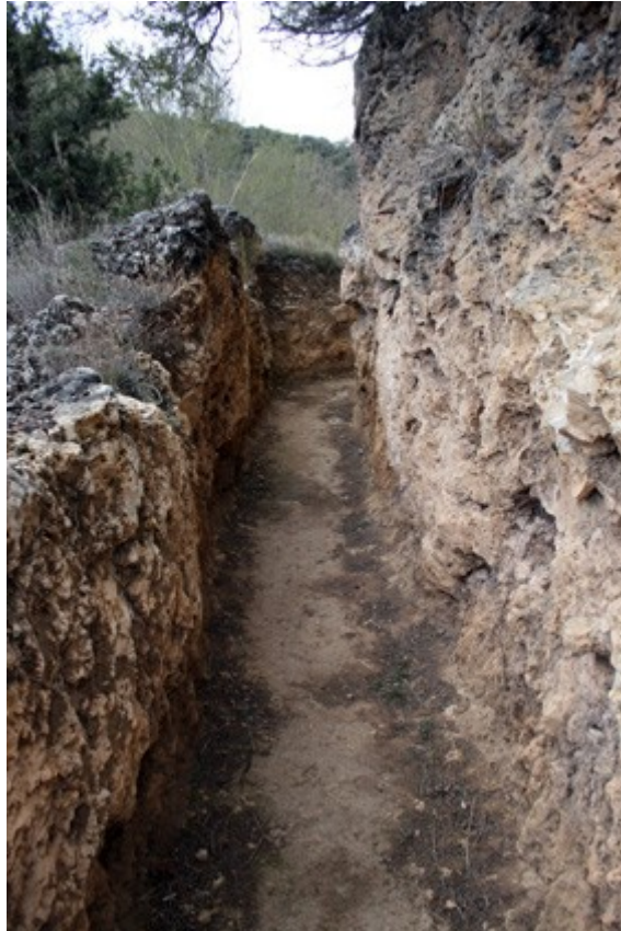
Specus del acueducto a cielo abierto cerca de la Galería del Túnel. (Foto: Roberto Lérica Lafarga 23/04/2008)
