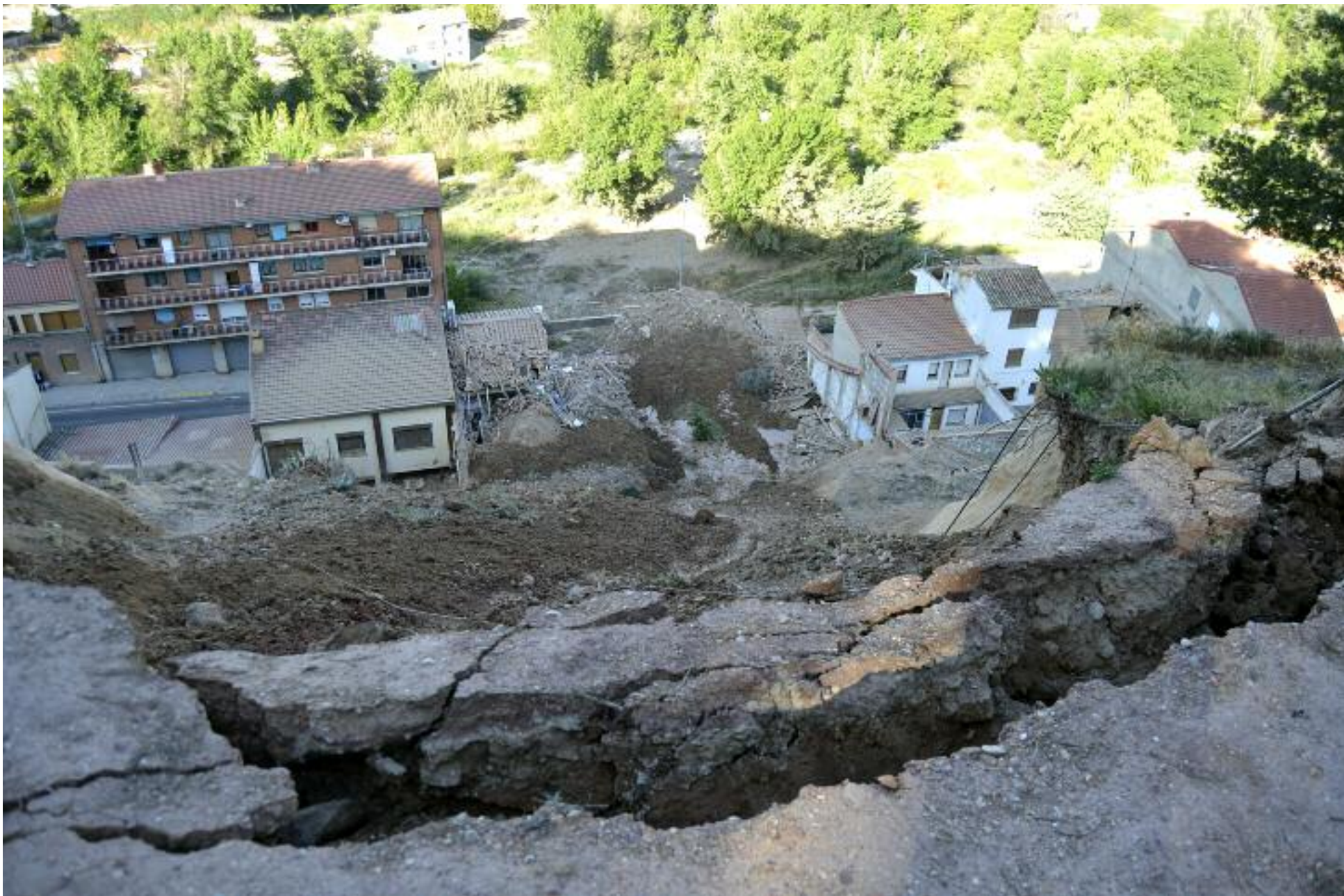
Perspectiva de la superficie desprendida y su impacto sobre la parte trasera de las viviendas, vista desde el punto del cerro de Pui Pinos que se resquebrajó. M. N.
