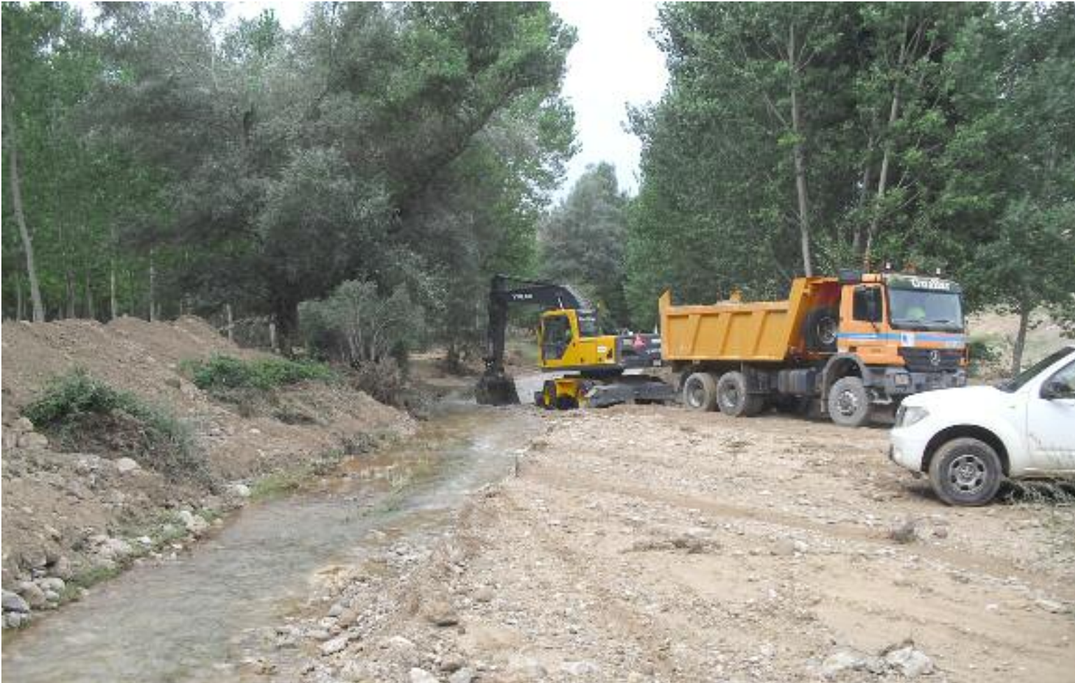
Trabajos de retirada de los sedimentos arrastrados por la rambla en el río Alfambra y recuperación del cauce original a un kilómetro de Villalba Baja
