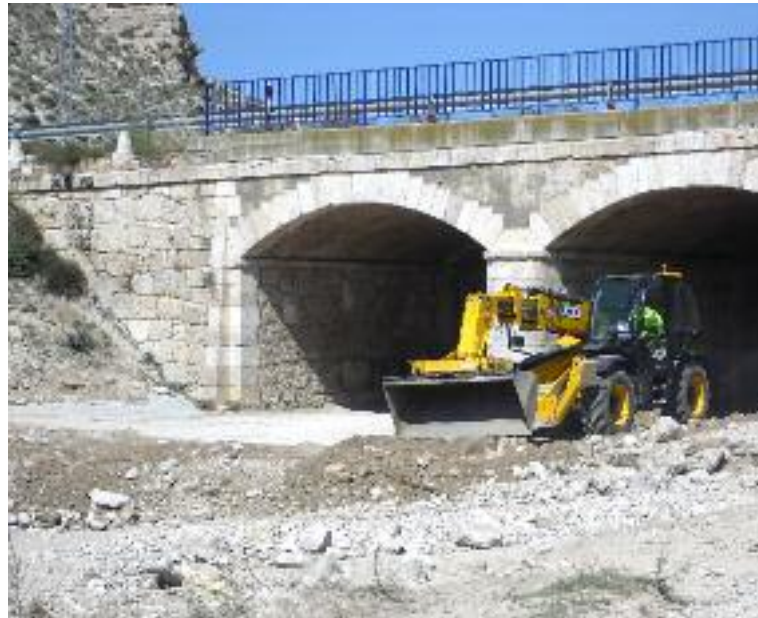
Fomento limpiando ayer los ojos del puente sobre la N-420 en la misma zona
